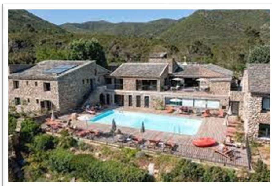
Vue extérieure après rénovation
